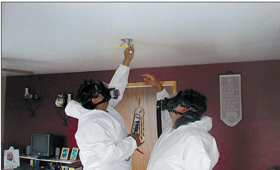
Généralement, il n'est pas nécessaire d'enlever la vermiculite contaminée, tant que celle-ci est immobile. Par précaution, pour éviter que des particules fines ne se retrouvent dans l'air ambiant, on peut boucher les ouvertures (par exemple celles des plafonniers) entre les pièces occupées et le grenier avec un scellant, qui doit être ignifuge s'il est utilisé près de fils électriques. Il faut alors se protéger à l'aide d'un masque à filtre HEPA, vendu dans les centres de rénovation.
