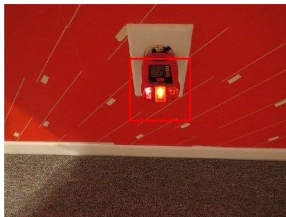
PRISE À POLARITÉ INVERSÉ DANS LE SALON AU SOUS-SOL.
