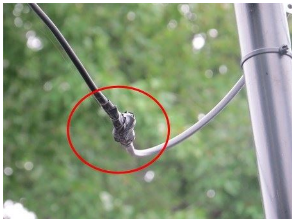
JONCTION RECOUVERTE DE RUBAN ÉLECTRIQUE SEULEMENT.
